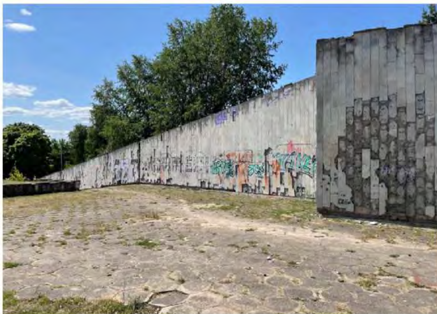
Pav. 3 Atraminių sienučių apdailos pažaidos
