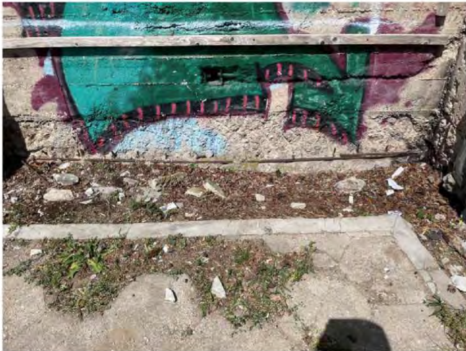
Pav. 6 Atraminių sienų armatūros apsauginio betono sluoksnio, apdailos pažeidimas
