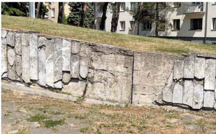
Pav. 4 Atraminių sienučių deformacinė-temperatūrinė siūlė, apdailos pažaidos
