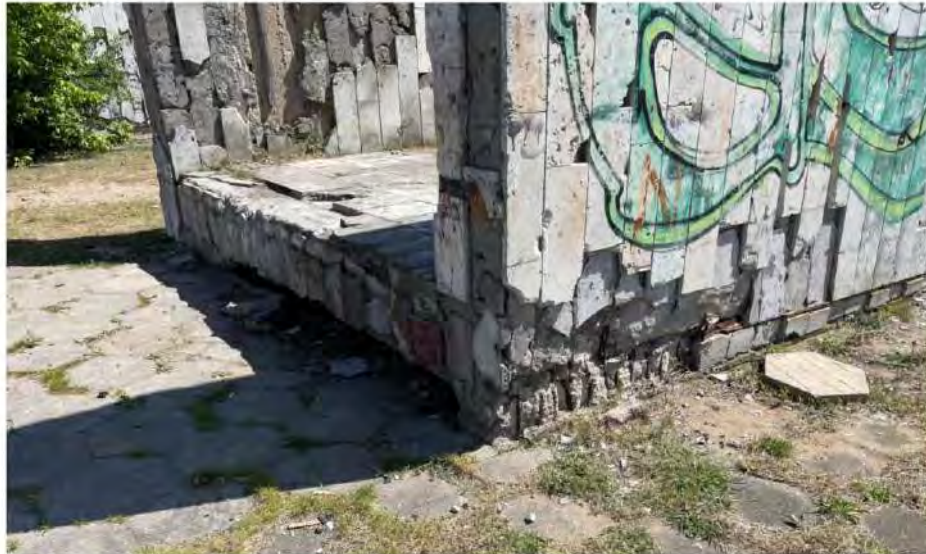
Pav. 5 Atraminių sienų armatūros apsauginio betono sluoksnio, apdailos pažeidimas
